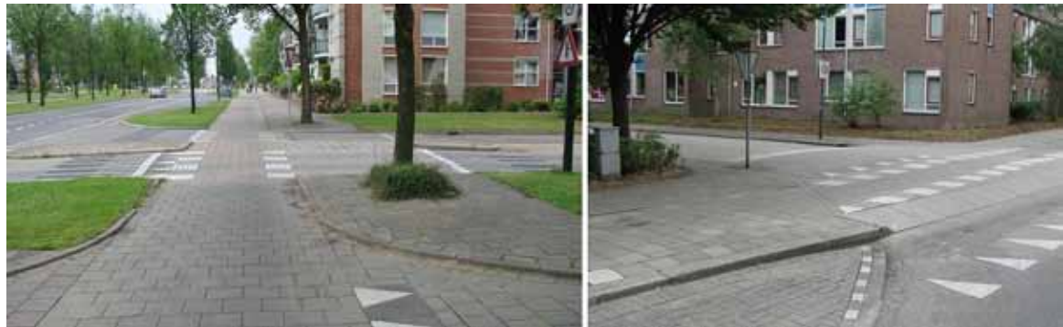
Figuur 2.2 Voorbeelden van verhoogd aangelegde fietsoversteekvoorzieningen
