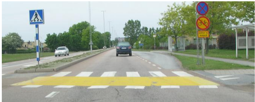
Figuur 4.2 Geel gemarkeerde oversteekvoorziening voor fietsers in Zweden
