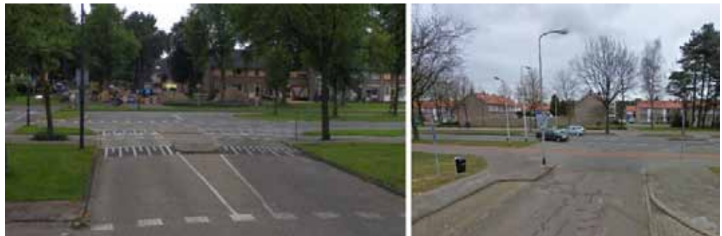
Figuur 7.1 Voorbeelden van fietspaden aangelegd op een drempel in twee onderzoekssteden
