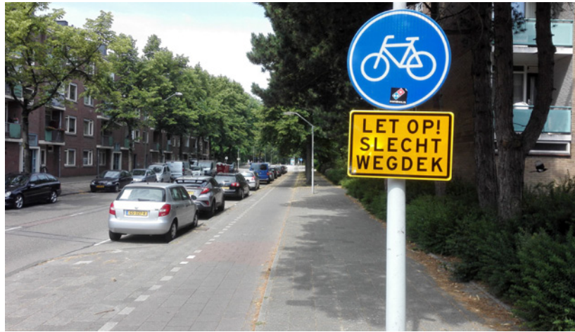
Werengouw: de Fietzersbond heeft bij de gebiedscommissie aandacht gevraagd voor de losliggende tegels. En... de tegels liggen weer goed!
