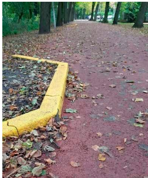
Een goedkope, maar tamelijk gevaarlijke manier om een obstakel op het fietspad aan te geven
