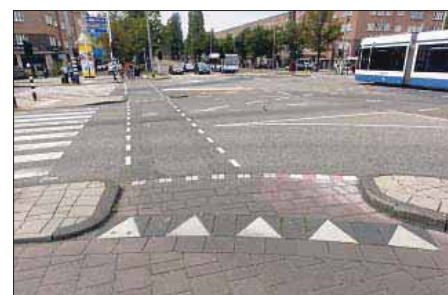
Bredere monding fietspad naar Berlagebrug
