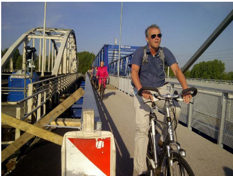
Tijdelijke brug ARK Nieuwegein, 2014
