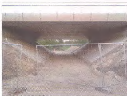
Viaduct Daveren in aanbouw
