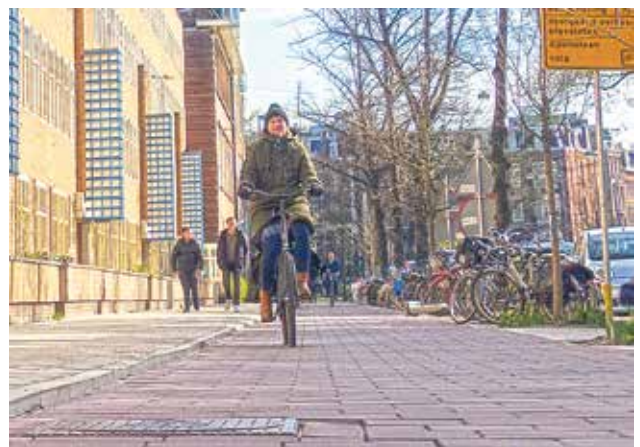
Fietspad verbreed, maar opnieuw met tegels en hoekige putdeksels en een onnodig verhoogde haakse stoeprand
